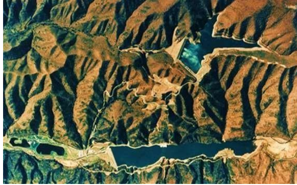
Figura 2.- Central hidroeléctrica reversible Bath County. Fuente: Google imágenes.
