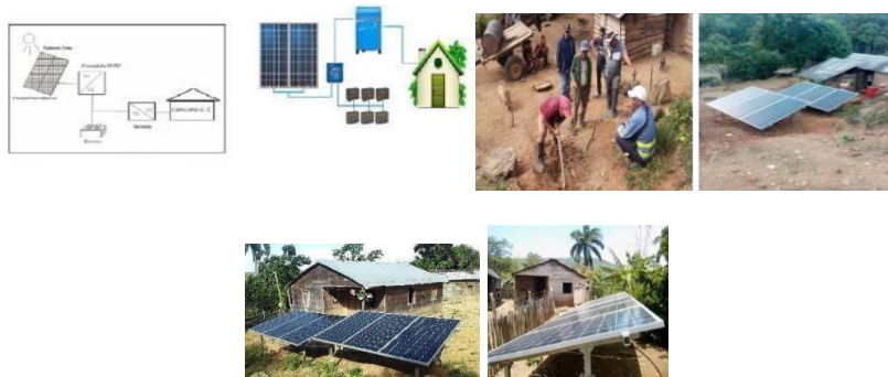
Figura 1. Electrificación con SFVA de 2,2 kWp en la comunidad el Palenque.
